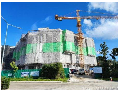
ภาพที่ 2.2-24 การติดตั้งนั่งร้านและผ้าใบกันฝุ่น
